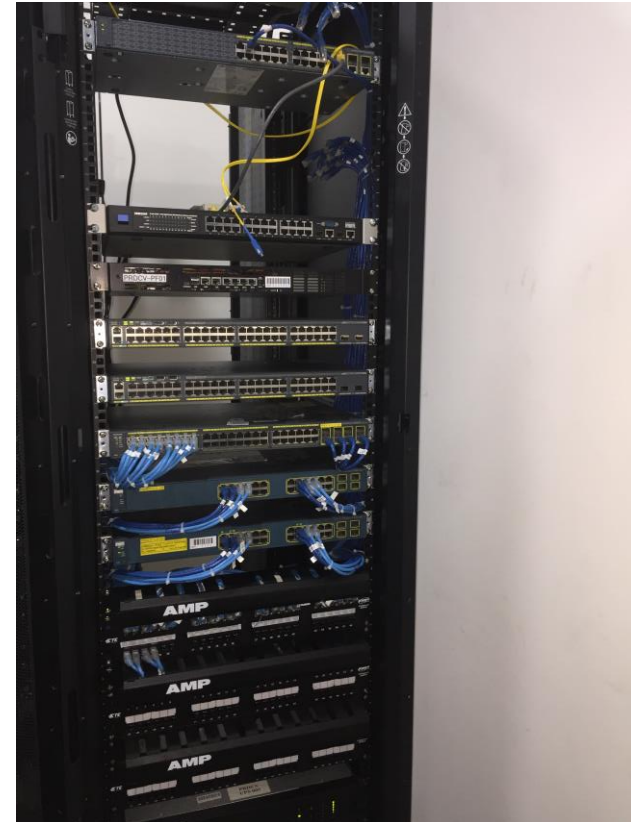
Công ty P*N*S*N*C Lắp đặt Hệ thống tủ Rack (8 chiếc) Server/SAN Storage/Core switch/PBX/ TA/ Camera
