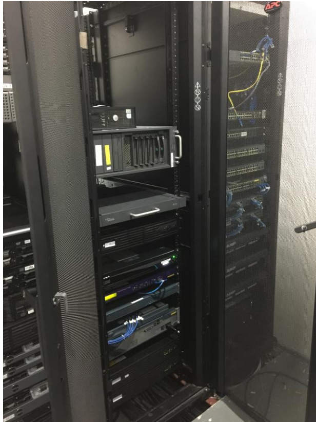
Công ty P*N*S*N*C Lắp đặt Hệ thống tủ Rack (8 chiếc) Server/SAN Storage/Core switch/PBX/ TA/ Camera
